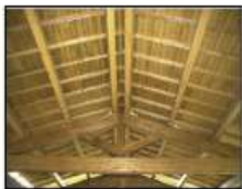
solai di copertura in legno
