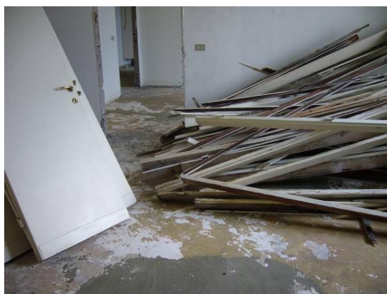
Figura 6: Fase di strip out : in primo piano, moduli per controsoffitto a quadretti, guarnizioni in plastica, porte e mostre in legno, scarti di legno riciclabili. [Fonte: Barcella C. (Comitato Tecnico European Demolition Association), "L'attività delle imprese europee e italiane di demolizione per il
