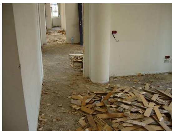
Figura 6: Fase di strip out : in primo piano, moduli per controsoffitto a quadretti, guarnizioni in plastica, porte e mostre in legno, scarti di legno riciclabili. [Fonte: Barcella C. (Comitato Tecnico European Demolition Association), "L'attività delle imprese europee e italiane di demolizione per il
