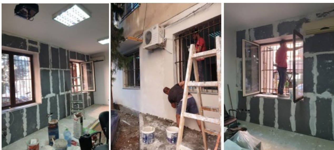
Figura 2 - Lavori di ristrutturazione
