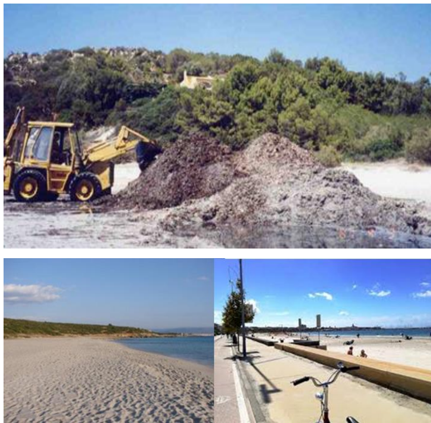
Figura 4 - Escavatore che rimuove vegetazione dalla spiaggia mescolandola a sabbia e rifiuti urbani. Con tale operazione l'intero cumulo diventa Rifiuto Urbano (RU) da smaltire o da inviare a impianto di trattamento.
